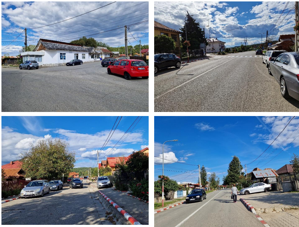
Figura 4.2. Situații de parcare neregulamentare cu consecințe asupra reducerii capacității de circulație și siguranței rutiere.
