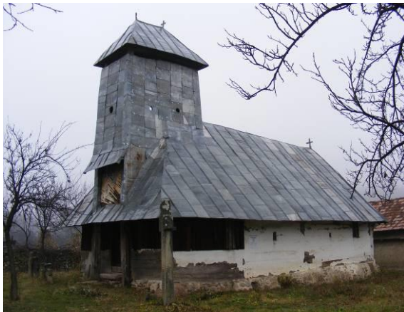
Vedere sud - vest
