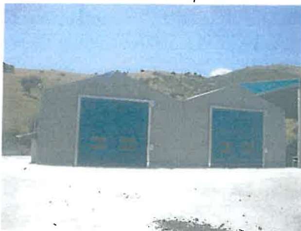
Fig 2: celule de tratare biologica
