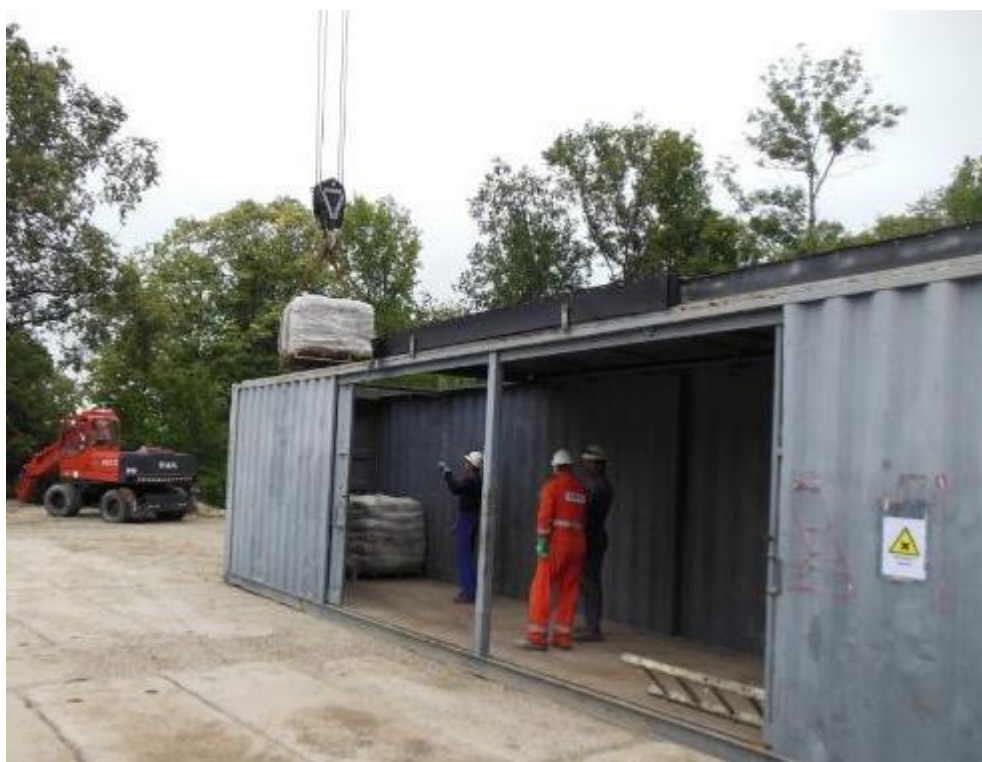
Figura nr. 1-6 Baracă de chimicale amplasată pe una din locațiile Amromco Energy SRL
