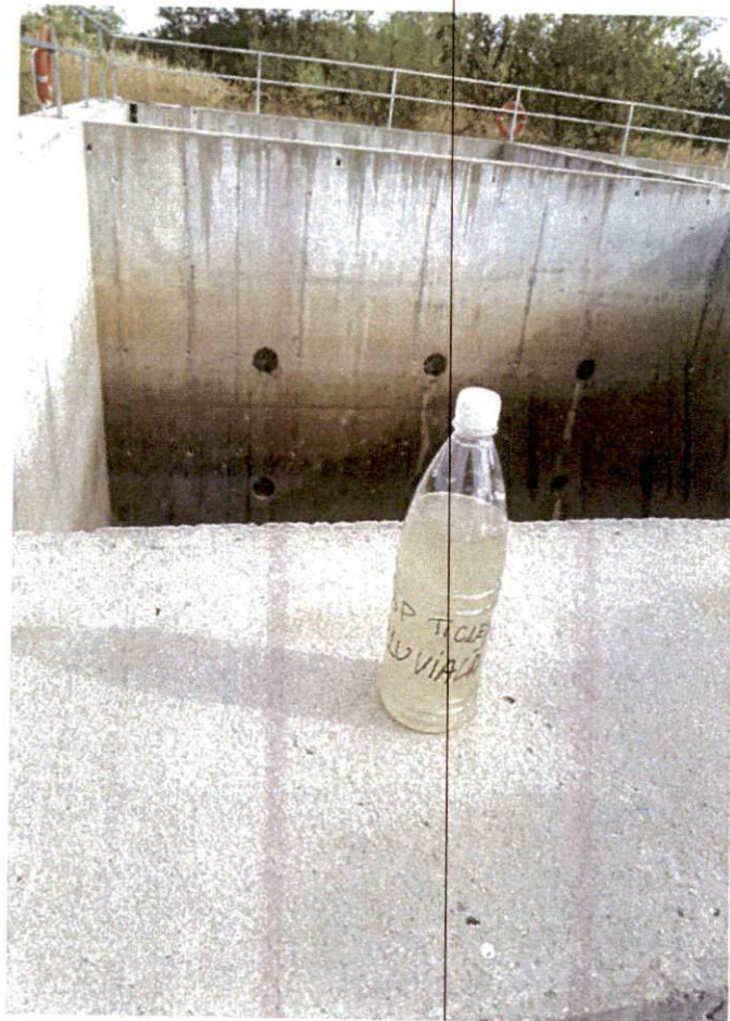
Poza 1: BP Ticleni- Apa pluviala
