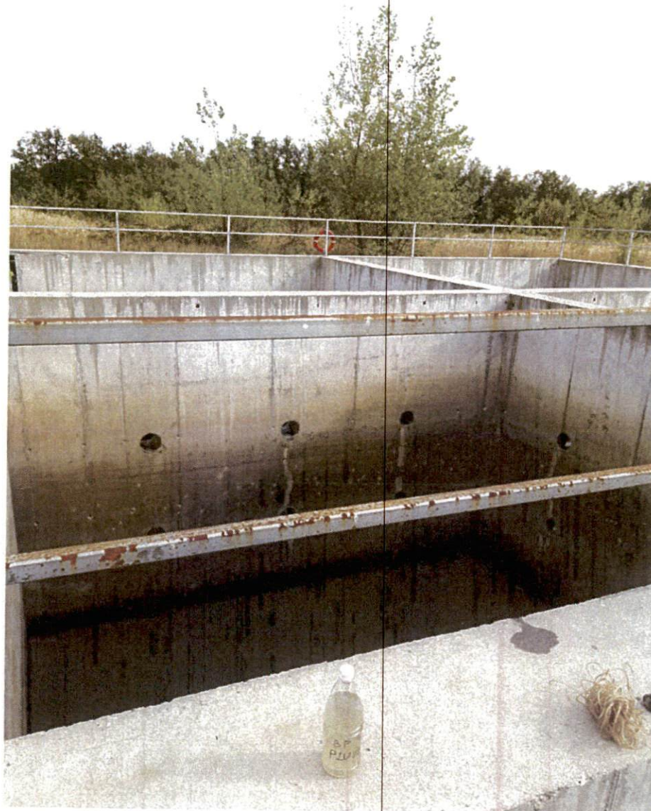
Poza 1: BP Ticleni- Apa pluviala
